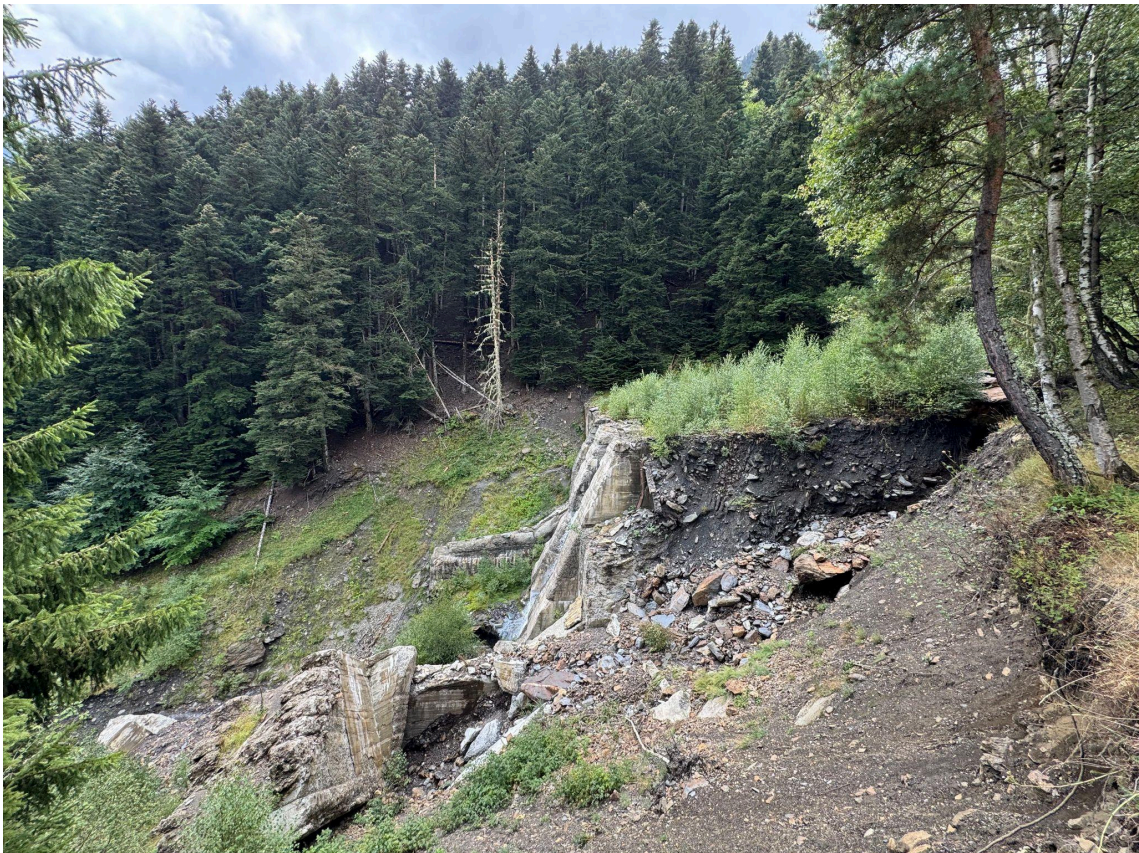
Figura nº1: Imagen donde se aprecian los efectos del no mantenimiento de las obras de restauración en el Val d'Aran en el río Valarties (Cataluña). Año 2025. (Fuente: REMP).
