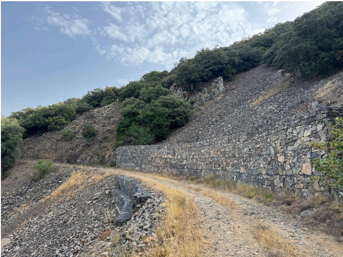
Figura nº1: Imagen donde se aprecia parte de la recuperación de uno de los muros de piedra seca en el Paraje Natural de Poblet (Cataluña). Año 2025. (Fuente: REMP).
