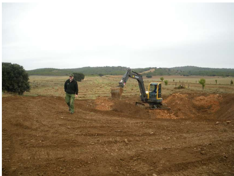
Creación de balsa junto a islote forestal. En la fotografía el APN, Julio Sánchez Plumed, impulsor del proyecto. Febrero de 2010.
