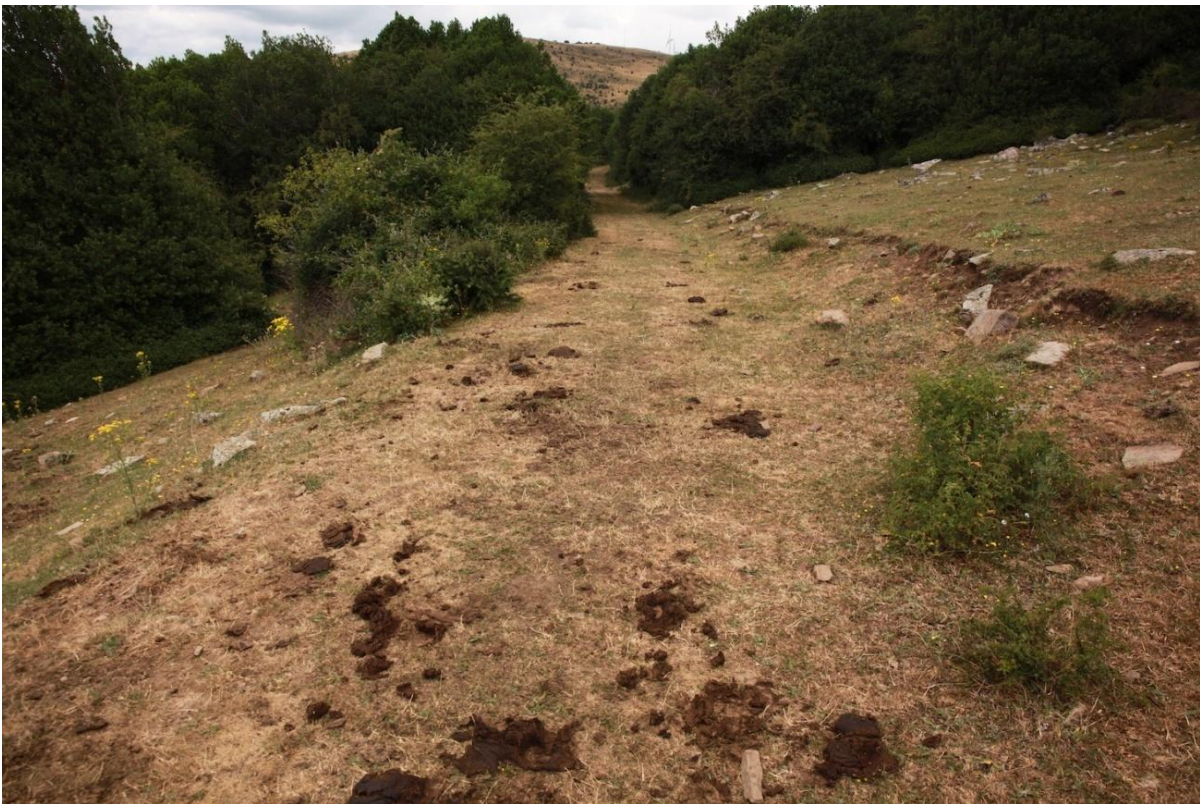
Figura 19. Pista forestal con el firme encespedado. Se observan gran cantidad de excrementos de ganado vacuno. En zonas húmedas, las pistas de pendiente no elevada y tránsito poco intenso se tienden a encespedar con rapidez. Si esto se consigue la erosión queda completamente retenida y existe una perfecta integración paisajística sin menoscabar la utilidad de cara a la extinción de incendios. Estas pistas son querenciosas para el ganado, por su baja pendiente y gran accesibilidad; a su vez, el uso ganadero favorece el encespedamiento y la conservación de la vía sin necesidad de inversiones. Arévalo de la Sierra, Soria.
