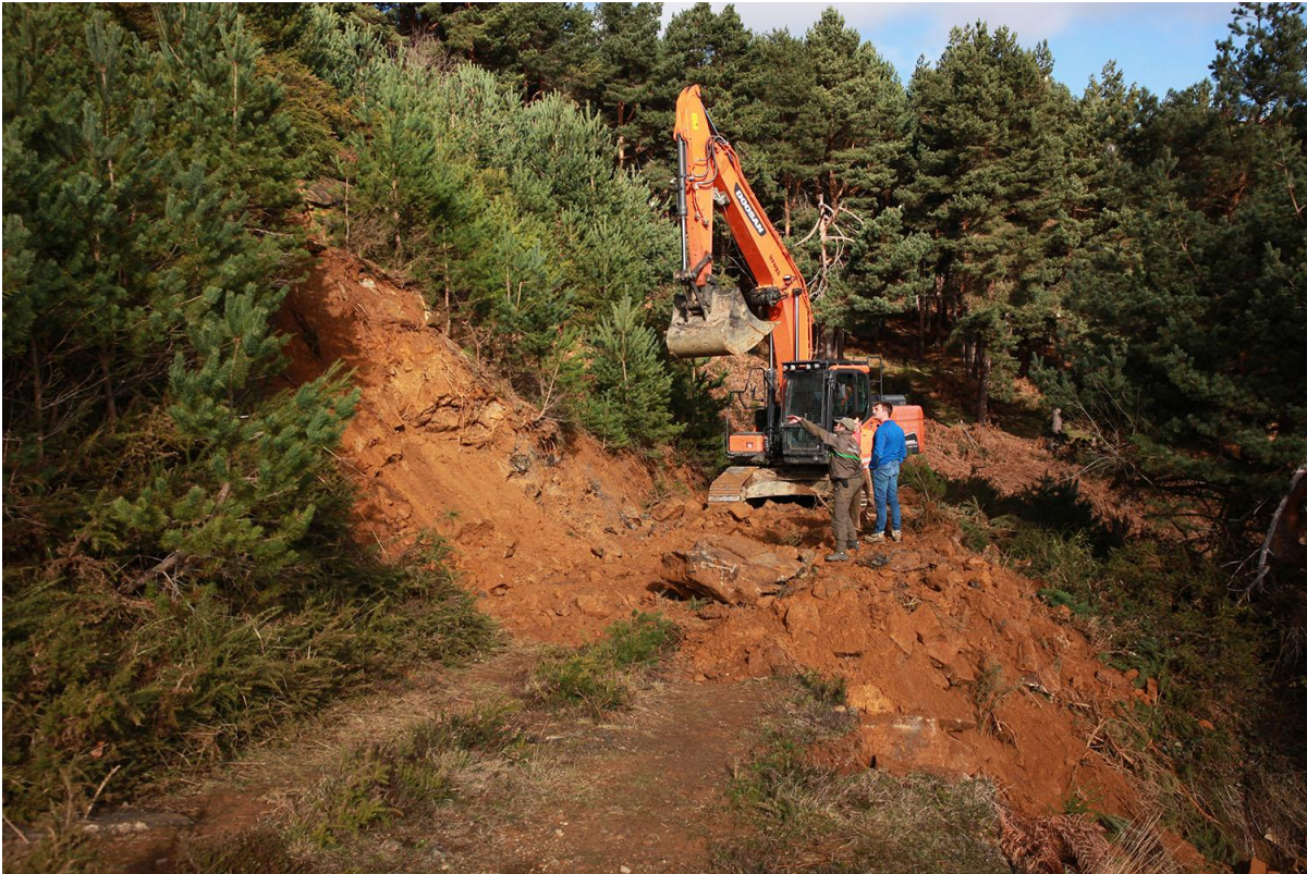
Figura 18. Retroexcavadora reparando un desprendimiento en una pista. El repaso ordinario se realiza en estas pistas secundarias con desbrozadora y solo cuando hay problemas de cierta entidad se recurre al uso de la maquinaria para mover el terreno, con la premisa de realizarlo en la cuantía imprescindible. En este caso se trata de una ladera inestable, debido a que los estratos buzcan en la dirección de la pendiente, y por eso la instrucción es, aquí especialmente, minimizar el movimiento de tierras. Las rocas caídas se aprovecharán para construir una pequeña escollera. Montecillo, Burgos.
