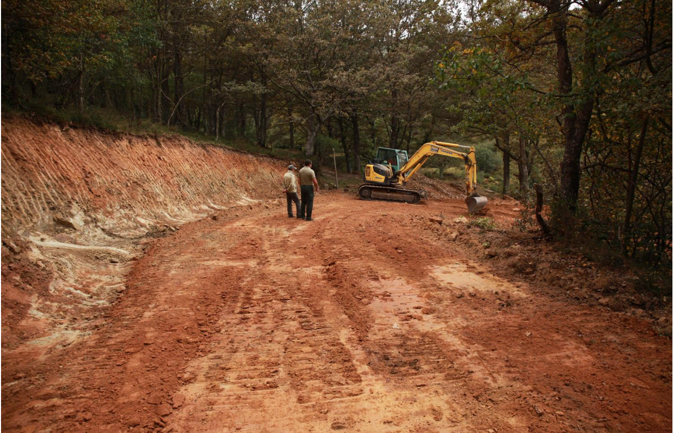
Figura 15. Ampliación de una curva para facilitar el tránsito de camiones. Una inversión de 600 euros (que se descontó de la madera aprovechada en el mismo monte) fue suficiente para realizar el trabajo. Es habitual que puntos críticos como este restrinjan los vehículos que pueden circular por las pistas, y que las soluciones sean relativamente baratas. Monte Hijedo, Burgos.
