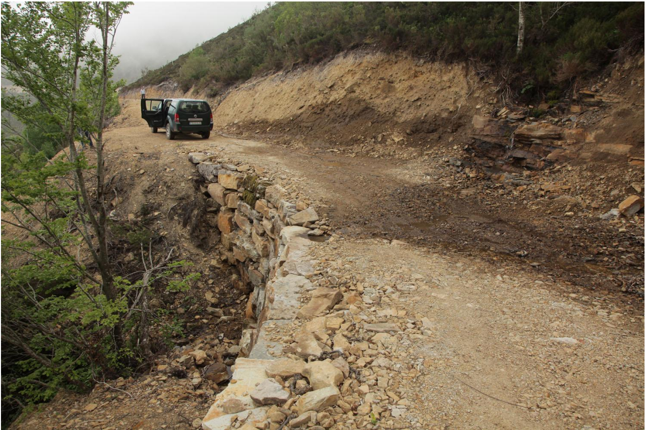
Figura 17. Pista abierta recientemente en terrenos de montaña. Las formas constructivas se han adaptado para minimizar el impacto y el coste de mantenimiento. La pista es estrecha, pero tiene volvederos, como el lugar donde está aparcado el vehículo. Obsérvese que no se han construido cunetas: en este lugar de precipitaciones sumamente elevadas (en torno a los 2.500 mm anuales), el agua se saca de la pista mediante badenes, que se construyen en todas las líneas naturales de escorrentía y, si estas no se aprecian, cada poco tiempo para evacuar el agua del firme de la pista. En los terraplenes bajo los badenes se construyen escolleras. La de la imagen es particularmente grande porque aquí se concentra mucha agua; a veces son solo unas pocas piedras. Estas se han sacado de la propia caja de la pista. En terrenos escarpados o inestables el metro a mayores en planta que requiere la cuneta incrementa el coste de construcción y mantenimiento, y un riesgo notable de que si se obstruye se genere un problema erosivo potencialmente grave. Además, la cuneta obliga a un desmonte mayor, que aumenta el impacto y dificulta el tránsito en la dirección de la pendiente de la ladera; en caso de que haya un gran salto en el desmonte conviene tallar pasos, al menos unos senderos que permitan acceder a la ladera (por ejemplo para dar un contrafuego). Las Machorras, Burgos.
